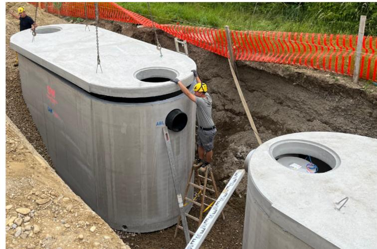
Beim Neubau der Firma Dennree in Wien wird die Entwässerung der befestigten Freifläche über einen Drosselschacht, einen Lamellenklärer und einen Mineralölabscheider von SW Umwelttechnik geleitet.
